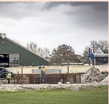
Start bouw. ARCHIEFFOTO PETER VAN AALST
